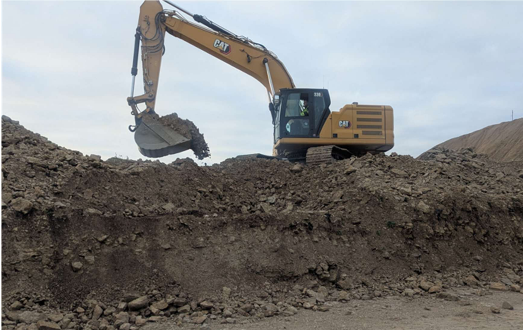
Foto 3.2. Seinapuhastus P-3/25. (Foto: M. Tammekänd 02.12.2025). Monoliitse lubjakivi pealispind asub 1,01 m madalamal võrreldes varu arvutuse mudelis esitatud kõrgusega. Varasem lasum abs kõrgusel 55,75 m, korrigeeritud lasum abs kõrgusel 54,74 m (Foto: M. Tammekänd, 02.12.2025).
