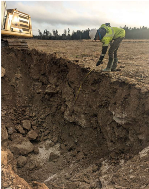
Foto 4.1.4. Kaevandis P-9/25 (plokis 1 aT) avaneb savikas moreen porsunud lubjakivi plaatidega. Monoliitse lubjakivi pealispind 0,45 m madalamal võrreldes varu arvutuse mudelis esitatud kõrgusega. Varasem lasum abs 55,38 m, korrigeeritud lasum abs 54,93 m.
